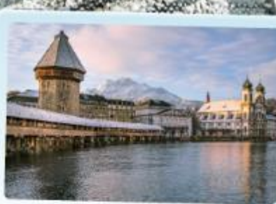
สะพานไม้ชาเปล
